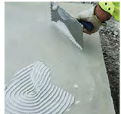
TASIKO®-Kleber direkt auf die vorbereitete Betonoberfläche flächendeckend aufgebracht.
