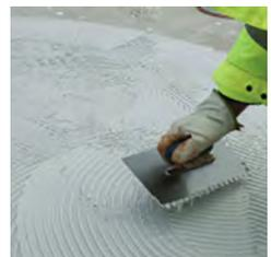
TASIKO®-Kleber wird mittels Zahnpachtel aufgebracht, deren Zahnung so gewählt wird, dass eine Klebefuge von mind. 2 mm entsteht.
