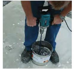
Mit langsam laufendem Rührwerk (max. 300 U/min.) gründlich durchmischen, bis eine homogene, schlierenfreie Masse entsteht.
